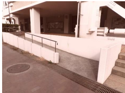
正面スロープ
