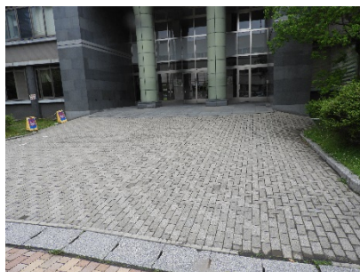
正面玄関前スロープ
