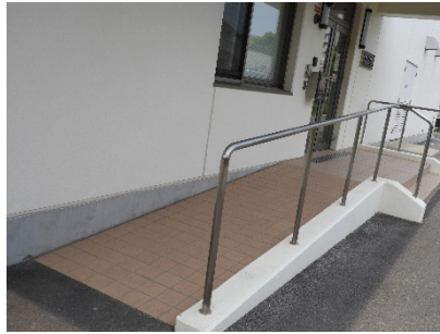
正面玄関横スロープ
