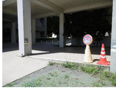
東側スロープ
