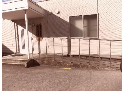
正面スロープ
