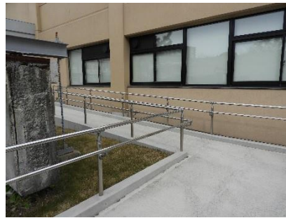
正面入口スロープ
