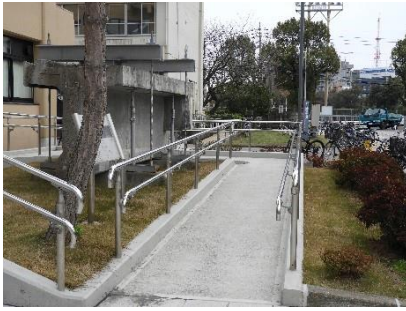
正面入口スロープ
