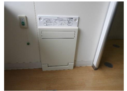
1階男子福祉型トイレフィッティングボード
