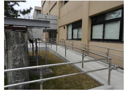
正面入口スロープ
