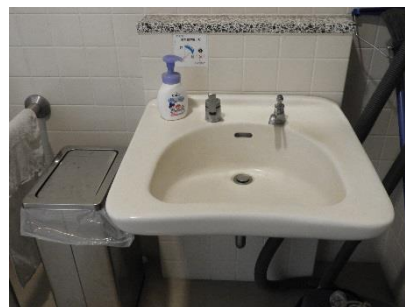
1階みんなのトイレ個室手洗い
