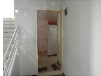
1階男子トイレ入口
