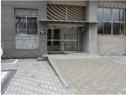
正面入口スロープ
