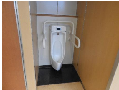
1階男子手すり付きトイレ
