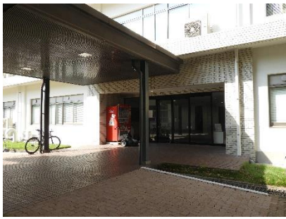
正面スロープ
