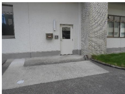
裏面スロープ
