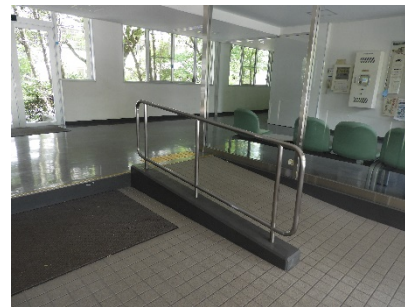
玄関内スロープ
