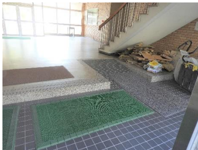
正面入口内スロープ
