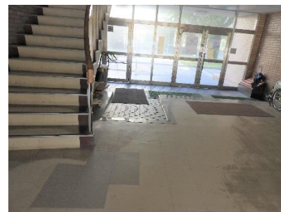
正面入口内スロープ
