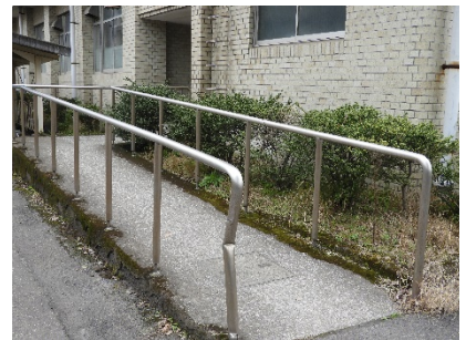
裏側スロープ
