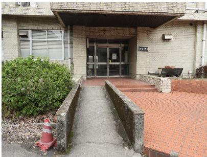
正面入口スロープ
