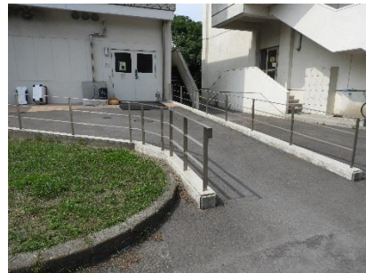
正面入口スロープ
