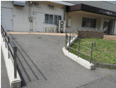
正面入口スロープ
