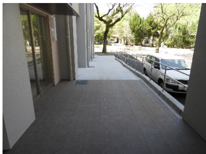
正面入口横スロープ
