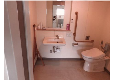
1階みんなのトイレ内手洗い
