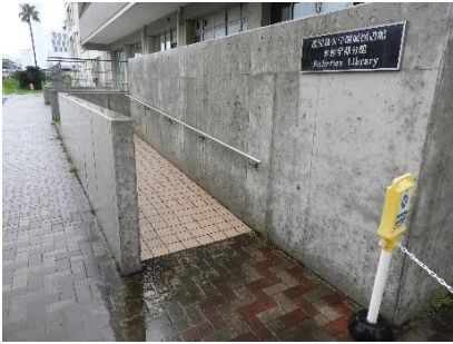
正面スロープ
