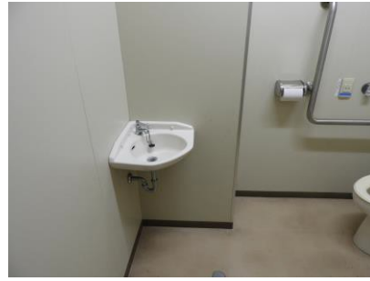
1階みんなのトイレ内手洗い
