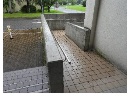
正面スロープ
