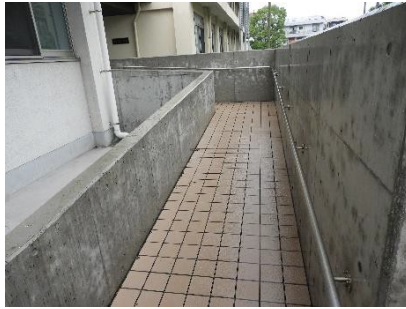
正面スロープ
