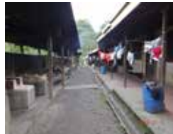
アキアレス・コーヒー園株式会社労働者用宿舎一部（5号宿舎、2号宿舎）（2019年11月、調査実施時）
